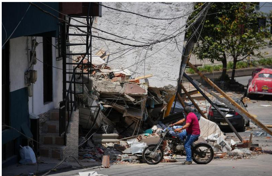
Un hombre observa los escombros de un edificio colapsado por un sismo, en Pereira, Colombia, el 14 de agosto de 2026. (Xinhua/Andrés Moreno)
