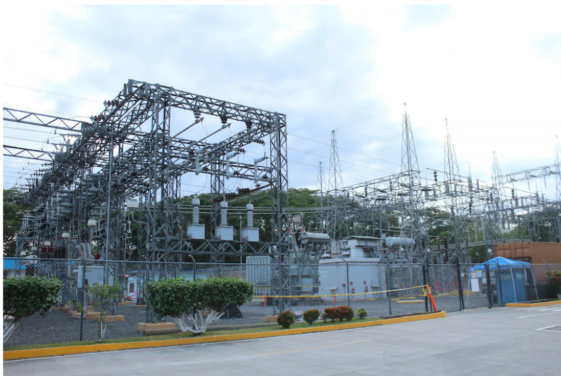
La SIGET ya no verá los temas de electricidad; solamente se encargará de las telecomunicaciones, así como el pliego tarifario. Foto: Diario Co Latino / Archivo.
