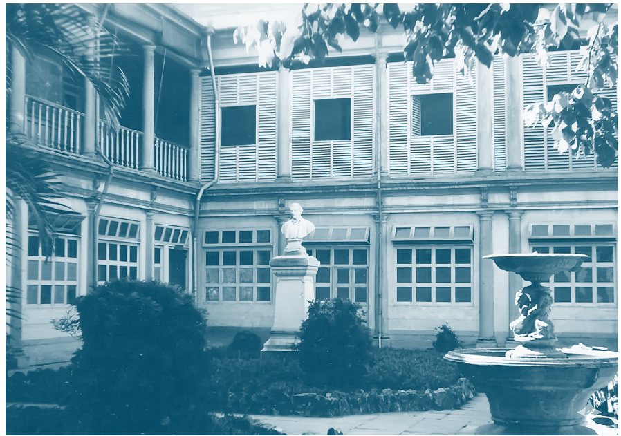
Patio interior del tercer edificio histórico de la Universidad de El Salvador, construido de madera y lámina troquelada. Se aprecian los dos niveles de la estructura, una fuente y el busto en mármol del intelectual nicaragüense Lic. Pablo Buitrago, catedrático y rector del Alma Mater nacional. Fotografía original proporcionada por el coleccionista Ing. Carlos Quintanilla, San Salvador.
