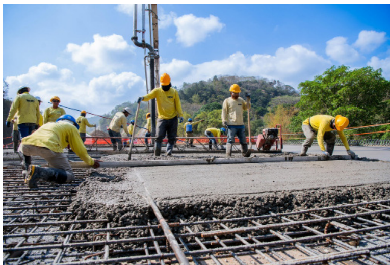
La información de la mayoría de proyectos de obras no son de conocimiento público, ya que el Gobierno los pone bajo reserva, lo que limita el control ciudadano. Foto: Diario Co Latino / Cortesía
