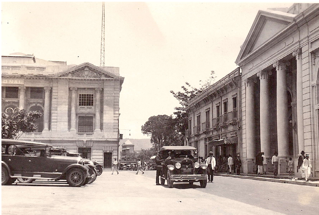
Una de las dos antenas de 18 metros de la radioemisora AQM-RUS-RDN, instaladas en el Teatro Nacional capitalino desde noviembre de 1925. Fotografía proporcionada por el Ing. Carlos Quintanilla, San Salvador.
