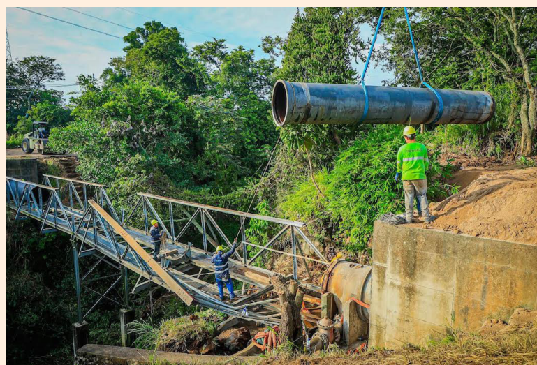
ANDA continúa con los trabajos en tubería dañada y construcción de un nuevo puente de soporte de la estructura. Foto Diario Co Latino/@ANDASV.
