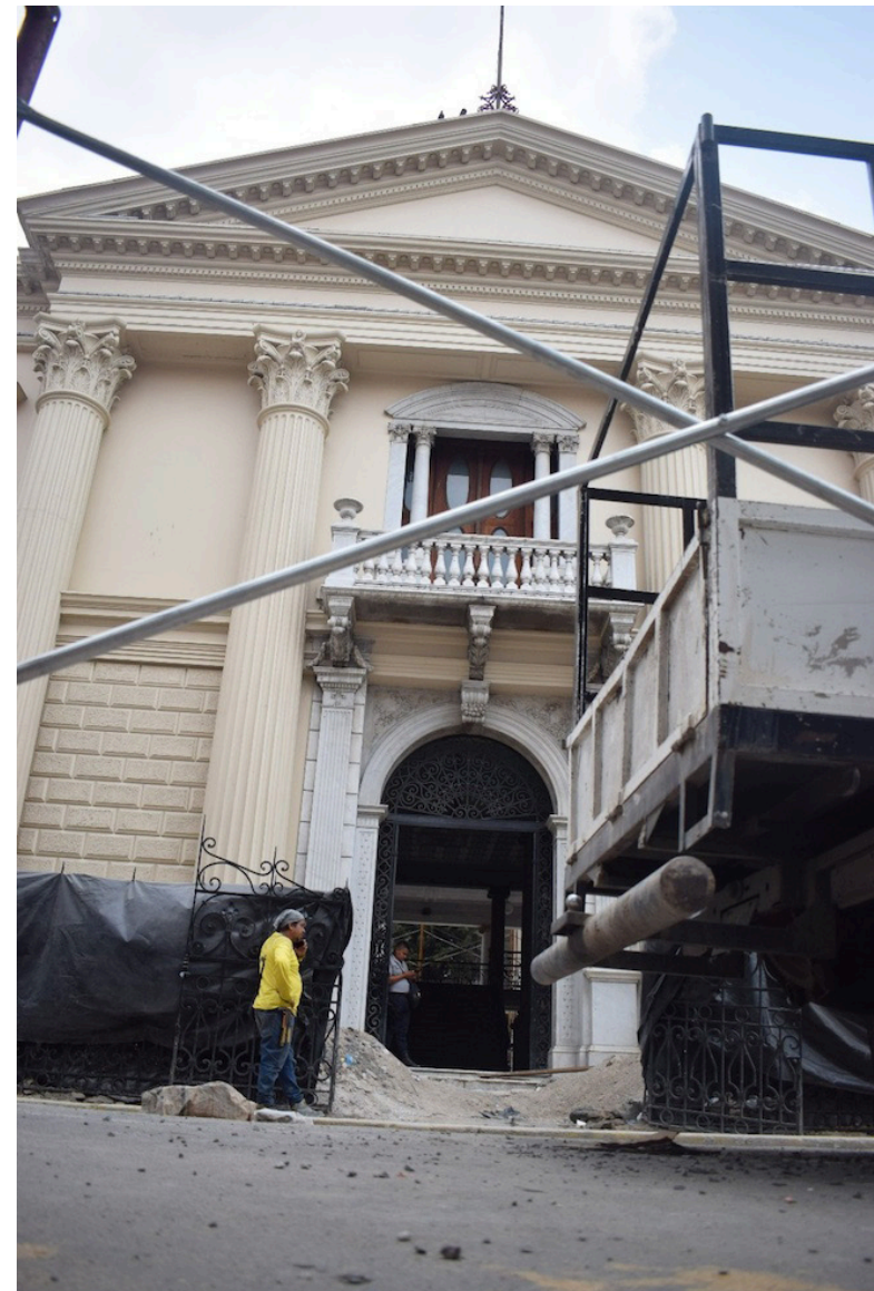
Las obras de remodelaciones al Palacio Nacional se espera que terminen antes del 1 de junio. Foto: Diario Co Latino/Gabriela Sandoval
