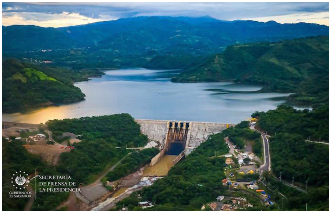
El presidente Nayib Bukele inaugurará la nueva Central Hidroeléctrica 3 de Febrero, desde San Miguel, obra que pretende contribuir a las necesidades energéticas de El Salvador. FOTO: DIARIO Co LATINO/CORTESIA.
