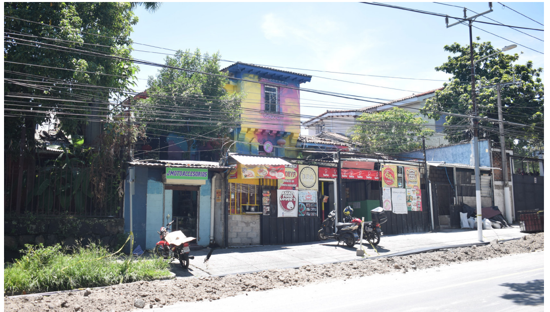
Negocios se ven afectados por los trabajos de cableado subterráneo que se realizan en la 6ª 10ª Calle Poniente, en las cercanías del parque Cuscatlán San Salvador. FOTO: DIARIO CO LATINO/ GABRIELA SANDOVAL.
