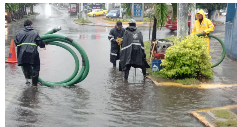
Equipos de la alcaldía de San Salvador trabajan en el desagüe de tragantes en diferentes calles de la capital, fin de prevenir anegamientos debido a las lluvias generadas por una onda tropical. FOTO DIARIO CO LATINO/@PRENSAAMSS.
