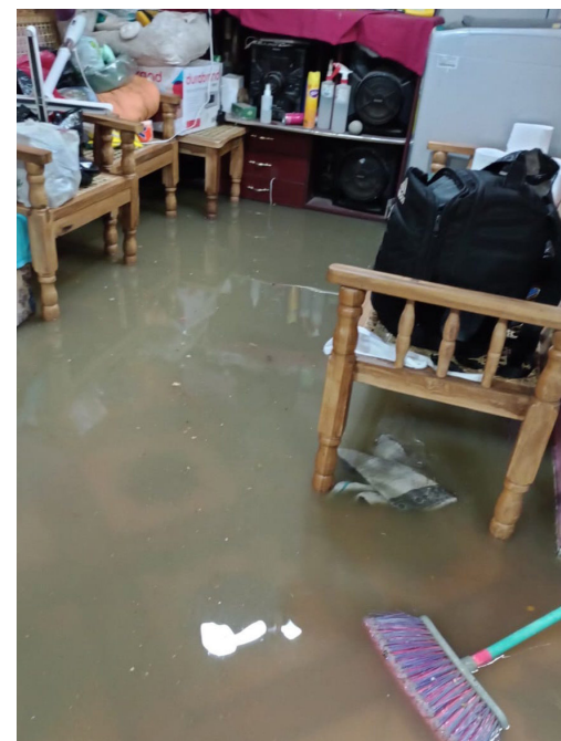
Seis viviendas de la comunidad Nueva Israel, San Salvador, resultaron inundadas por el colapso de aguas negras, debido a las últimas lluvias. FOTO DIARIO CO LATINO/ CORTESÍA.
