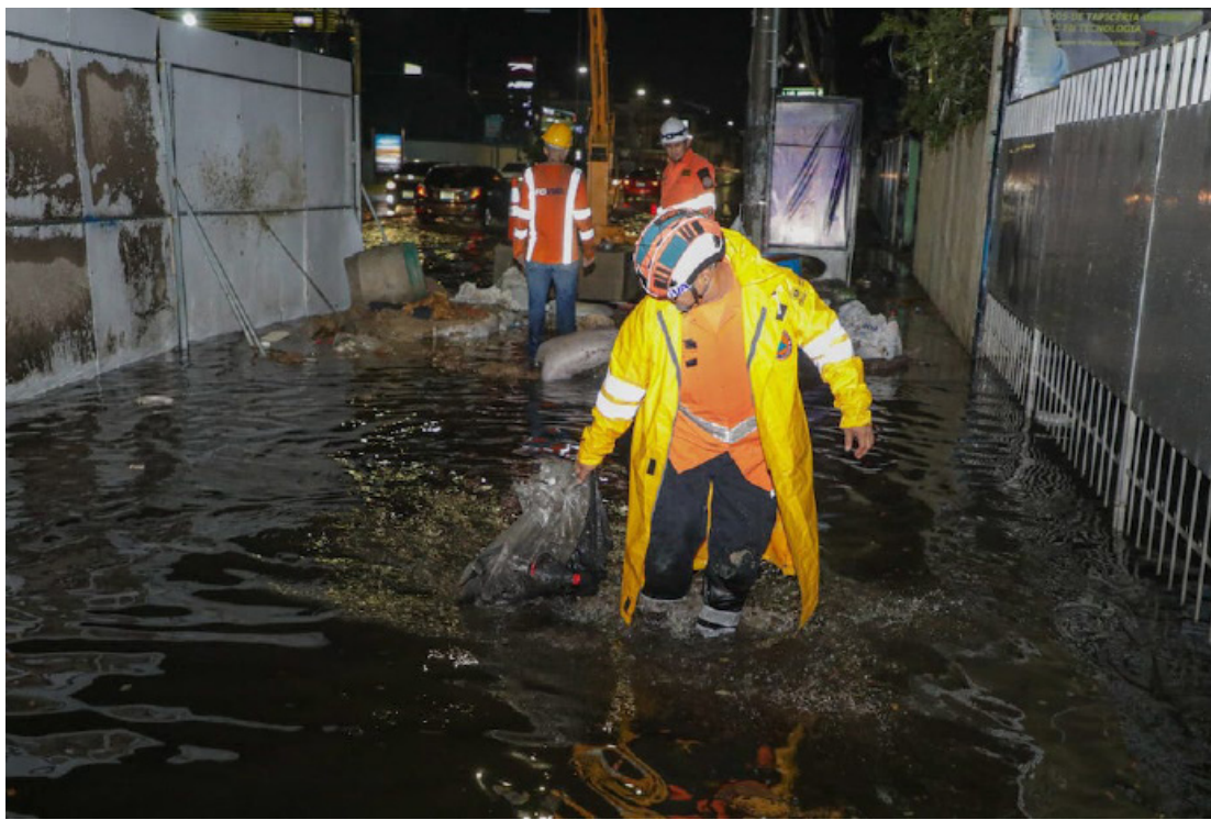
Debido a las últimas lluvias el sector de la 49 avenida sur, en San Salvador volvió a inundarse, personal de Protección Civil acudió al lugar para drenar el agua. FOTO DIARIO CO LATINO/@PROCIVILSV.
