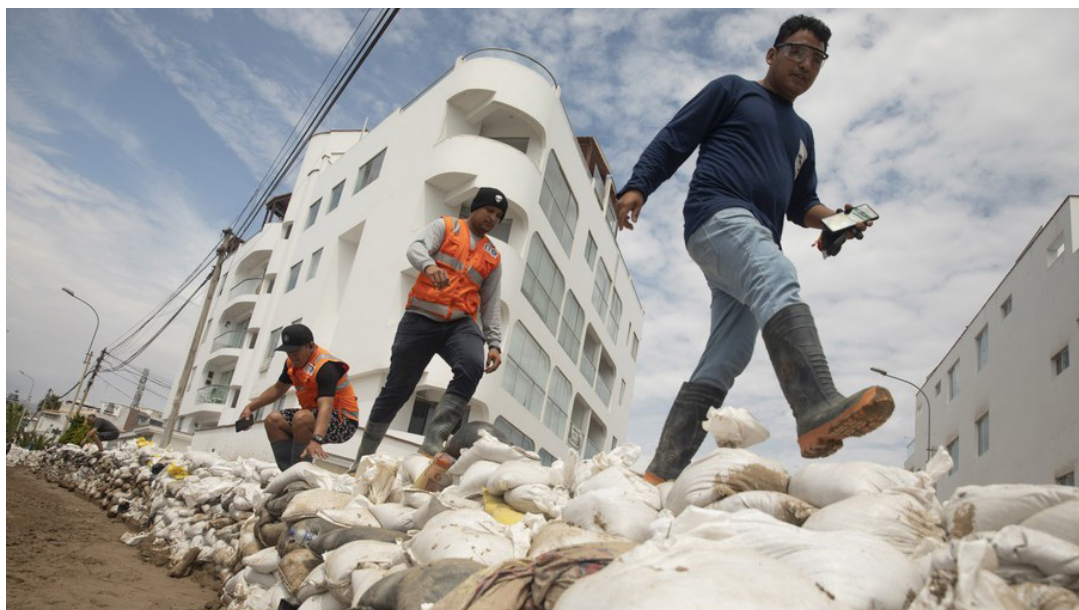
Personas caminan sobre una barricada construida para contener avalanchas de lodo debido a las lluvias intensas, en el distrito de Punta Hermosa, en el sur de Lima, Perú. (Xinhua/Mariana Bazo)
