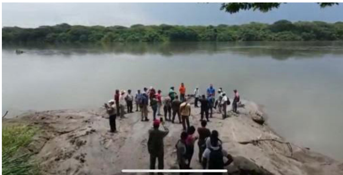
Miembros de la comunidad Taura y Rancho Grande, junto a autoridades del MOP y alcaldía municipal de Tecoluca, observan uno de los tramos más deteriorados y colapsados por la erosión en el río Lempa. Las demandas de los pobladores a CEL a una pronta intervención y al MARN, a prohibir la extracción de arena del río Lempa. FOTO DIARIOCOLATINO/CORTESIA CRIPDES.
