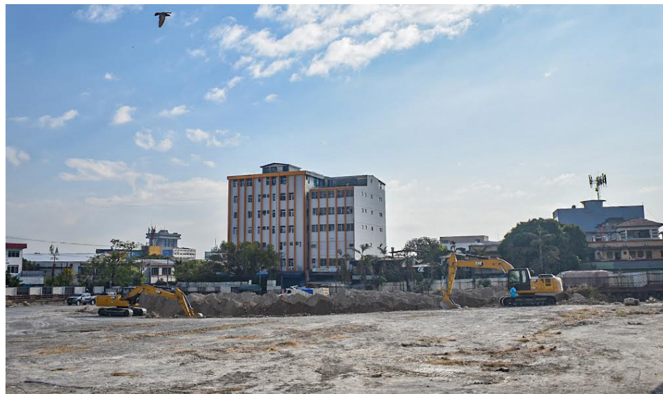
Dos excavadoras remueven la tierra en el centro del predio.
