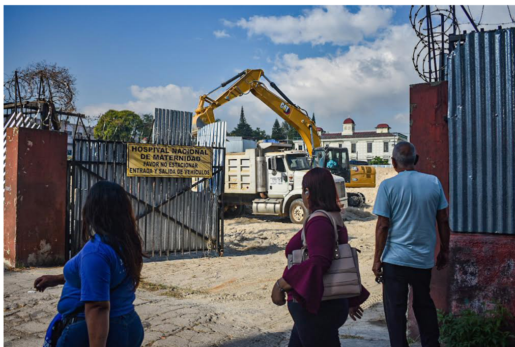
Transeúntes observan el trabajo de la DOM en el predio del ex hospital de Maternidad, donde se construirá el nuevo Hospital Rosales. FOTO: DIARIO CO LATINO / SAMUEL AMAYA.
