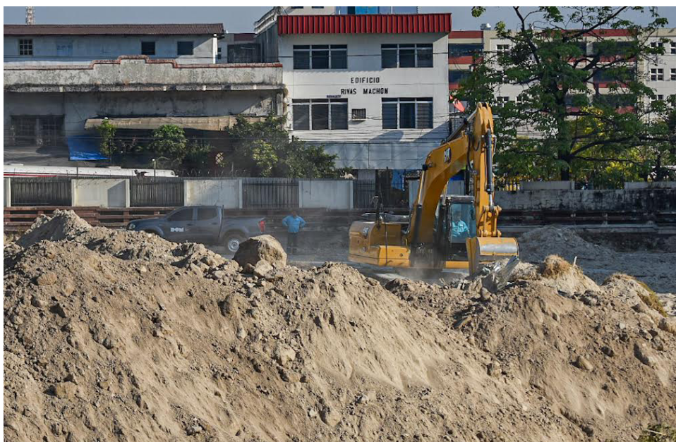
Desde el martes, trabajadores de la DOM han asistido al lugar de construcción para remover tierra; esto ha provocado una gran cantidad de polvo en los alrededores. FOTO: DIARIO CO LATINO / SAMUEL AMAYA.
