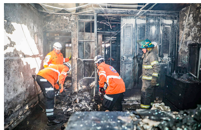
Una casa de la colonia Campos de Villavicencio, pasaje Brasilia, en San Salvador, fue consumida por un incendio provocado por un cortocircuito. FOTO DIARIO CO LATINO/@BOMBOSV.
